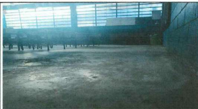
Foto 4: CAMBIO DE PISO A PISO CERAMICO
