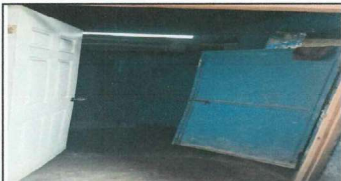
Foto 5: CAMBIO DE PUERTAS DE BAÑOS DE 0.70 MTS X 1.70MTS.
