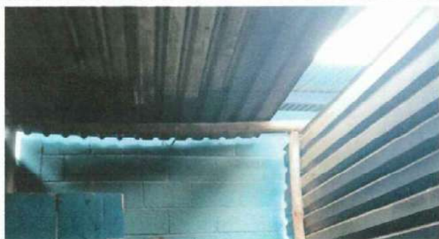
Foto 1: CAMBIO DE ESTRUCTURA DE TECHO
