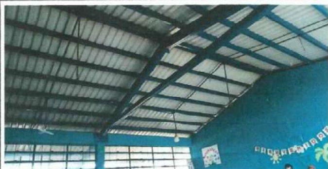
Foto 6: REPARACIONES DEI SISTEMA ELECTRICO
