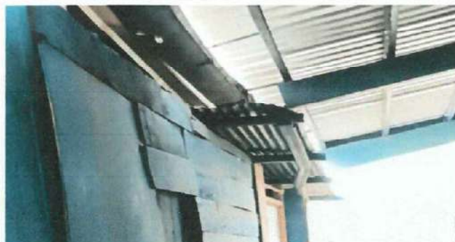
Foto 2: CANALES Y BAJADAS PUVIALES
