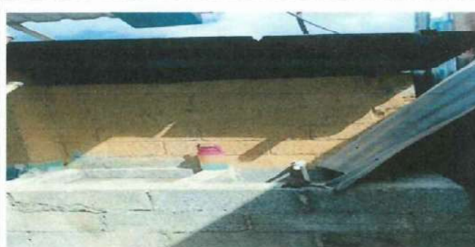
Foto 7: REPARACIÓN DE COCINA
