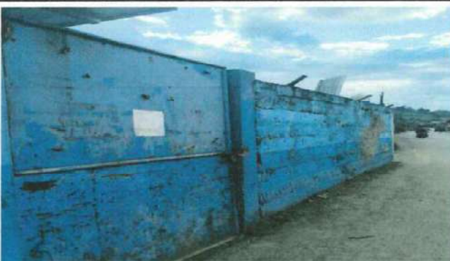
Foto 3: CAMBIO DE PORTON Y TALLADO DE PARED
